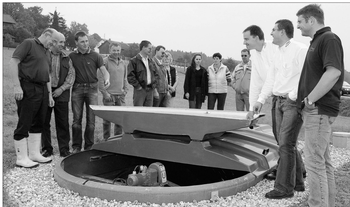
Bürgermeister Georg Riedl (von links), Klärmeister Alfons Hasbauer, Planer und Sachverständiger Horst Eger mit den Dorfbewohnern sowie Richard Altmann, der die Montage vornahm, Herbert Reissnecker und Tobias Brenker von der Firma Klargester. (Foto: Dixius)
